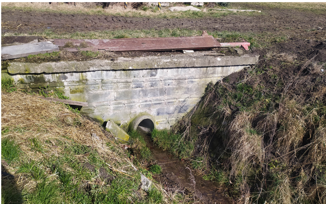
Obr.6 Polní cesta C9 – propustek určený k rekonstrukci.
